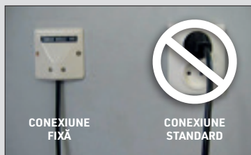
CONEXIUNE FIXĂ (HUBER 360® EVOLUTION) ȘI CONEXIUNE STANDARD (INTERZISĂ)
