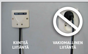
KIINTEÄ LIITÄNTÄ (HUBER 360® EVOLUTION) JA VAKIOMALLINEN LIITÄNTÄ (KIELLETTY)
