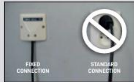
固定连接（Huber 360 ® Evolution） 和标准连接（禁止）
